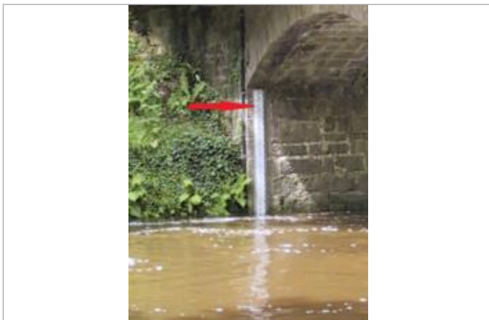
Echelle limnimétrique à la station du Léguer à Pluzunet-Le Vieux Marché
