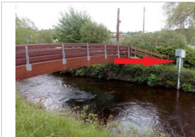
Station hydrométrique du Léguer à Belle-isle-en-terre
