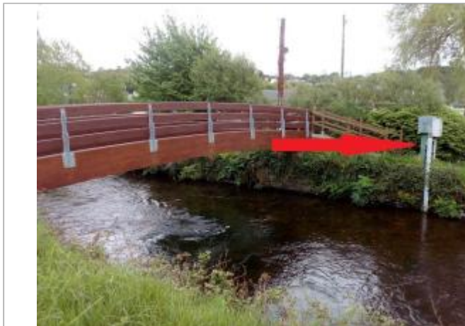
Station hydrométrique du Léguer à Belle-isle-en-terre
