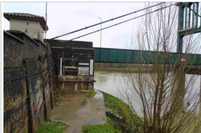
Vue du site - Photo Géosphair
