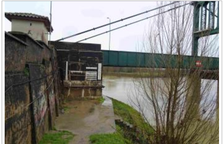
Vue du site - Photo Géosphair
