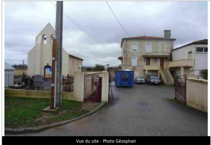
Vue du site - Photo Géosphair
