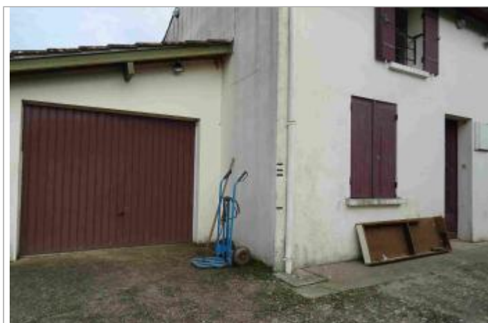
Vue du site - Photo Géosphair
