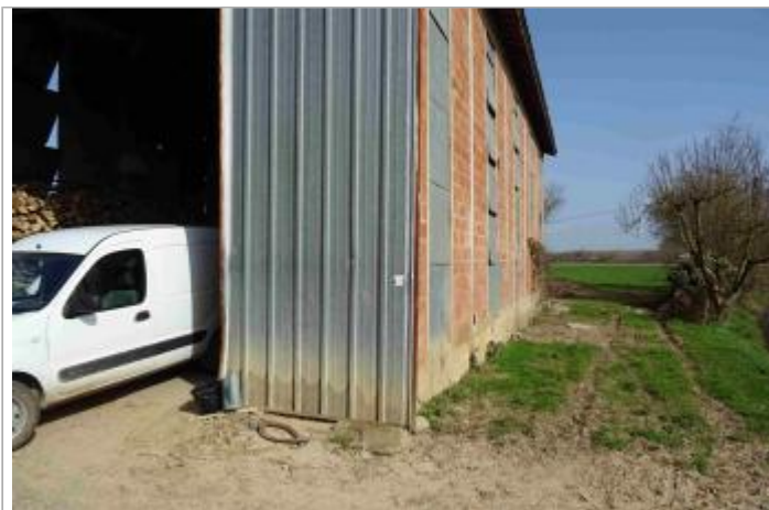
Vue du site - Photo Géosphair
