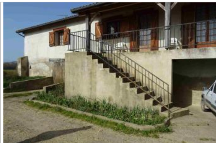
Vue du site - Photo Géosphair
