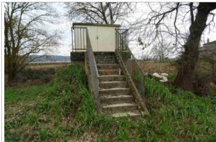
Vue du site - Photo Géosphair
