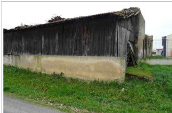
Vue du site - Photo Géosphair
