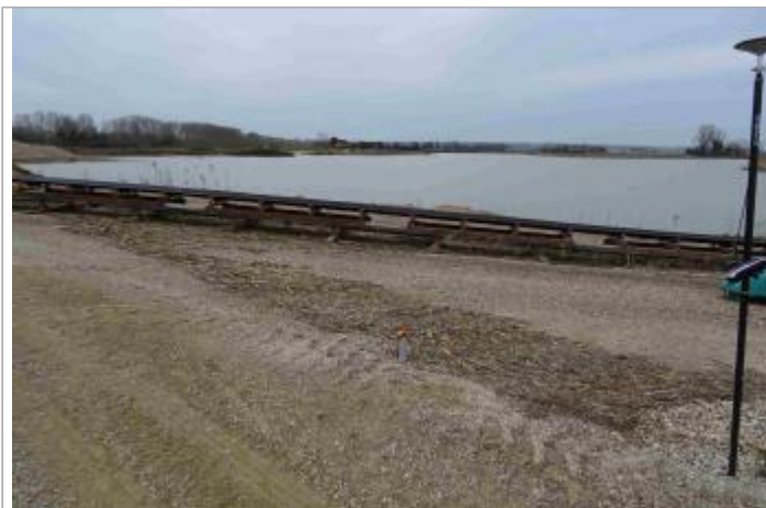
Vue du site - Photo Géosphair
