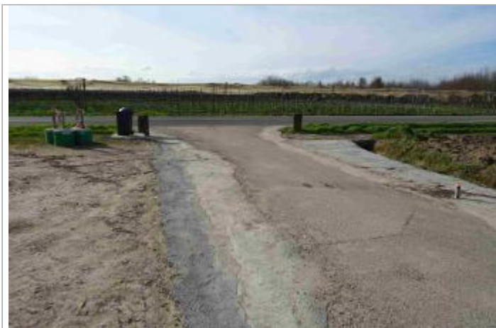
Vue du site - Photo Géosphair
