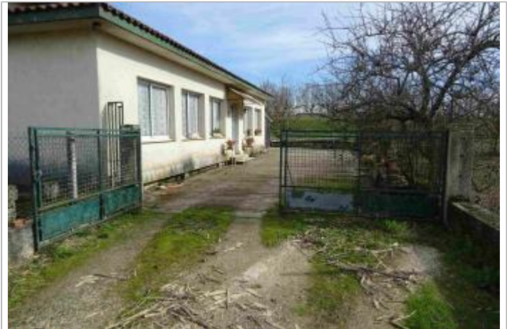
Vue du site - Photo Géosphair
