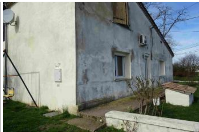
Vue du site - Photo Géosphair
