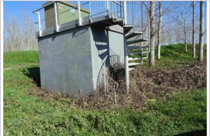
Vue du site - Photo Géosphair
