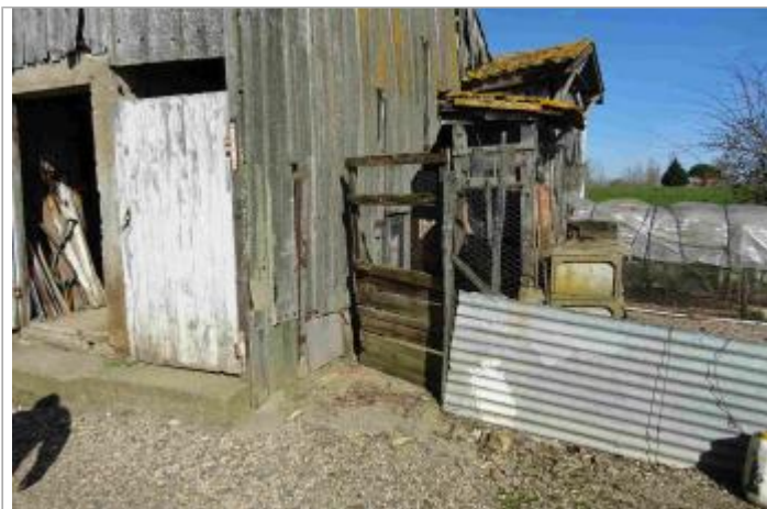
Vue du site - Photo Géosphair
