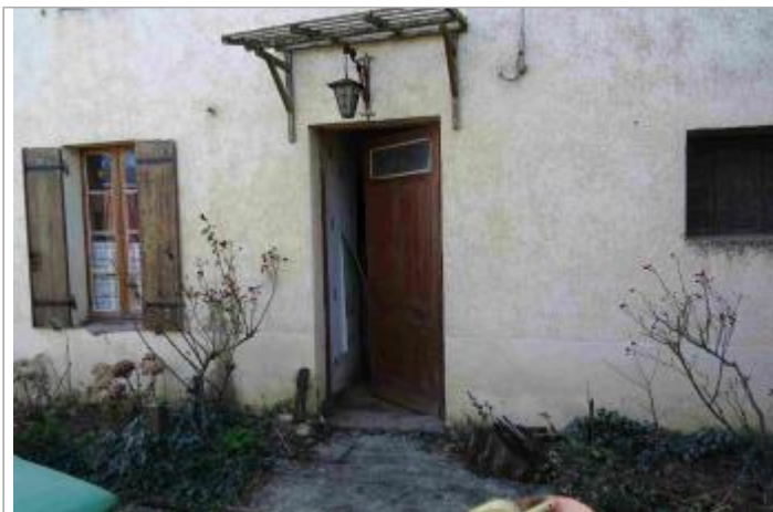
Vue du site - Photo Géosphair
