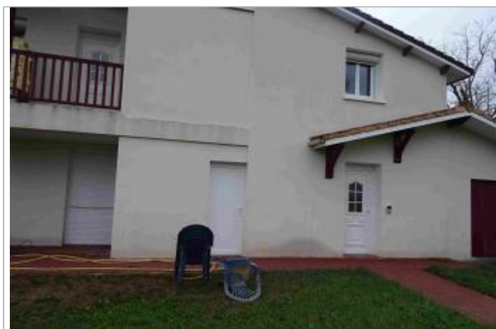
Vue du site - Photo Géosphair
