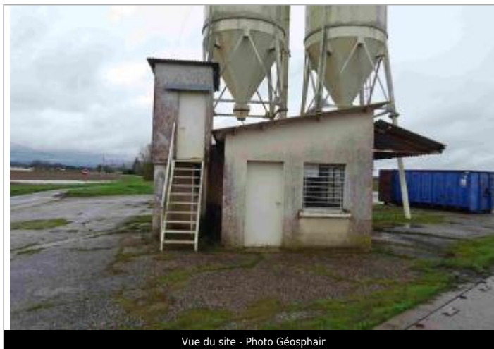
Vue du site - Photo Géosphair
