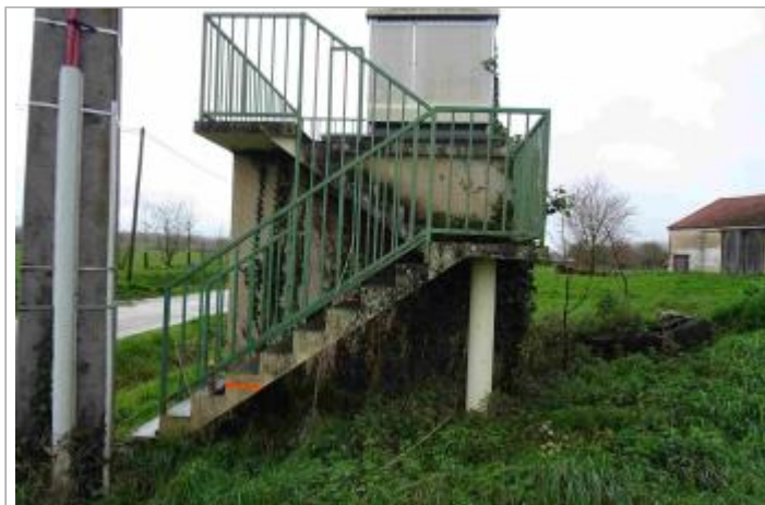
Vue du site - Photo Géosphair
