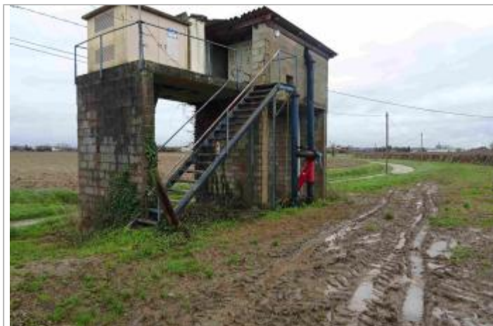
Vue du site - Photo Géosphair
