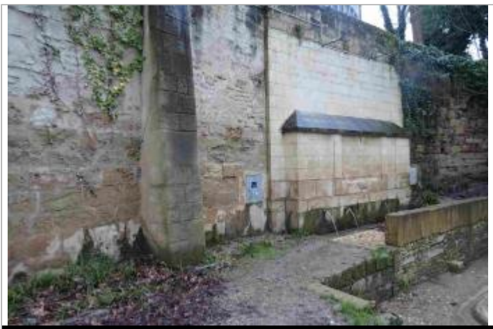
Vue du site - Photo Géosphair
