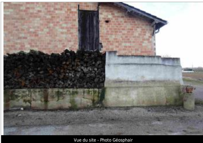
Vue du site - Photo Géosphair
