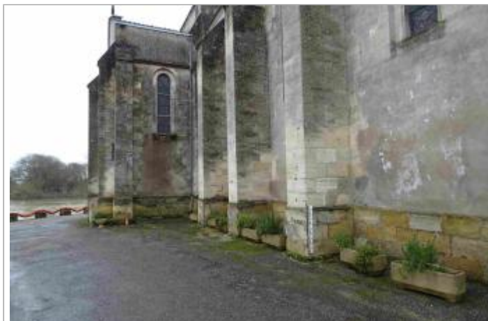
Vue du site - Photo Géosphair
