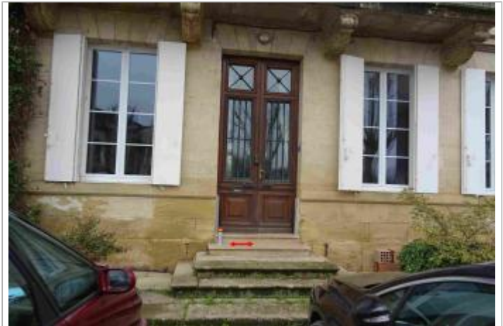
Vue du site - Photo Géosphair
