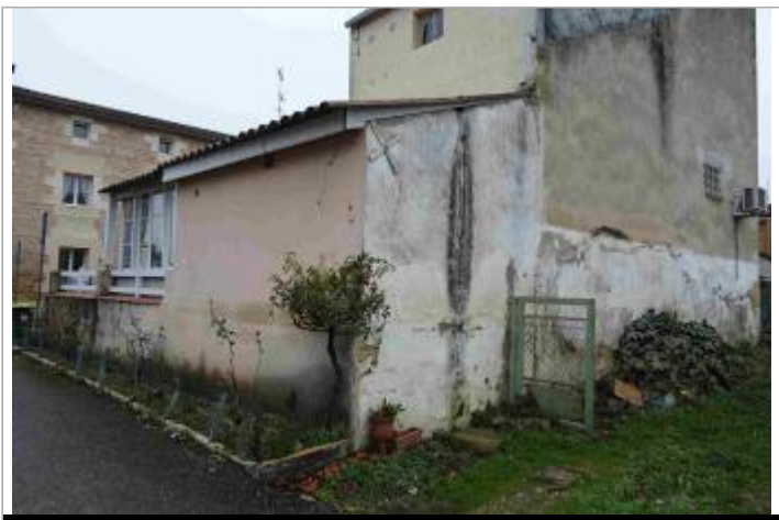
Vue du site - Photo Géosphair
