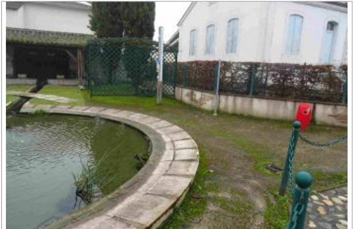
Vue du site - Photo Géosphair
