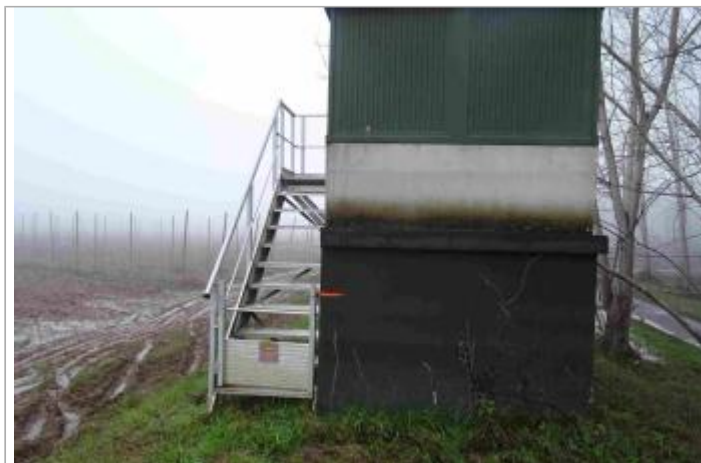
Vue du site - Photo Géosphair
