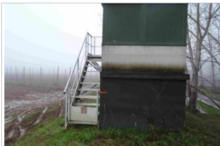
Vue du site - Photo Géosphair
