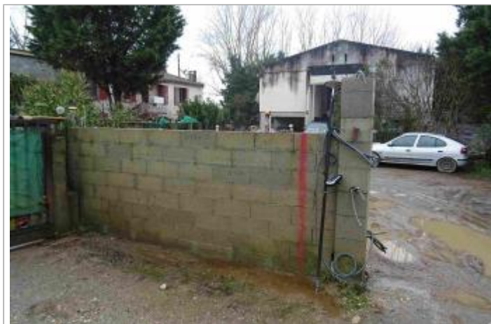
Vue du site - Photo Géosphair
