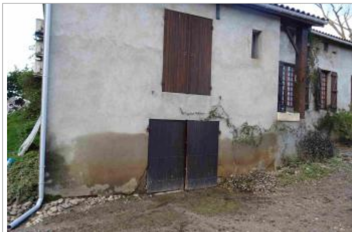
Vue du site - Photo Géosphair
