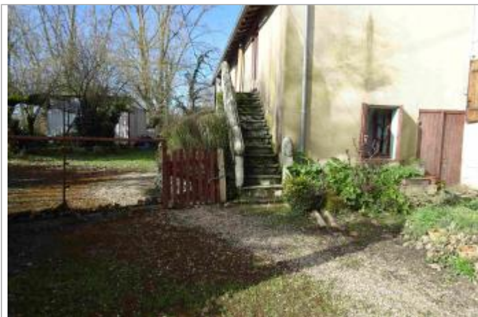
Vue du site - Photo Géosphair
