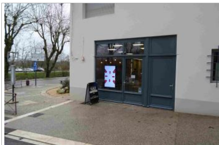
Vue du site - Photo Géosphair
