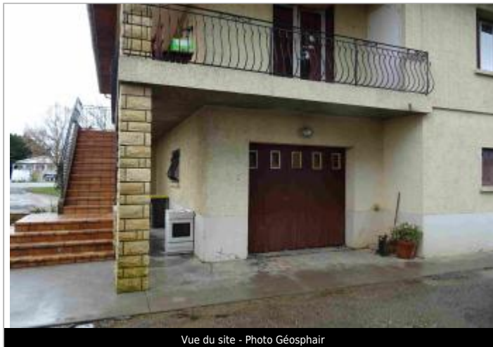
Vue du site - Photo Géosphair
