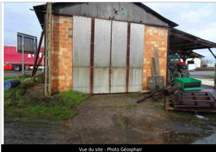
Vue du site - Photo Géosphair
