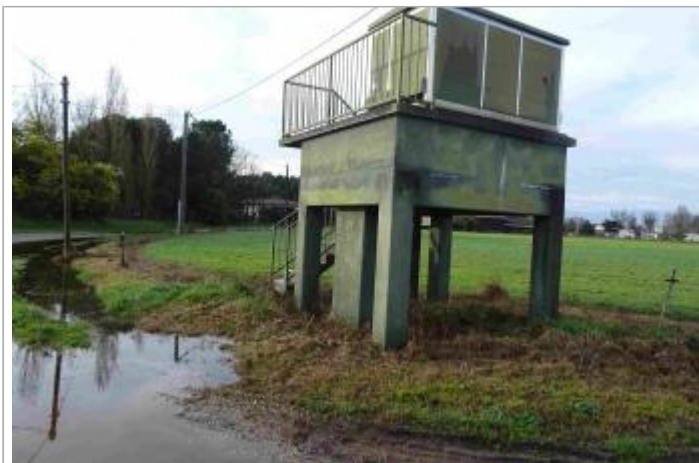
Vue du site - Photo Géosphair
