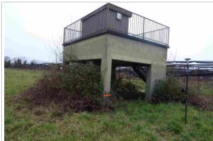
Vue du site - Photo Géosphair
