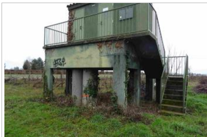
Vue du site - Photo Géosphair
