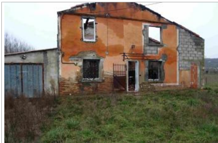
Vue du site - Photo Géosphair
