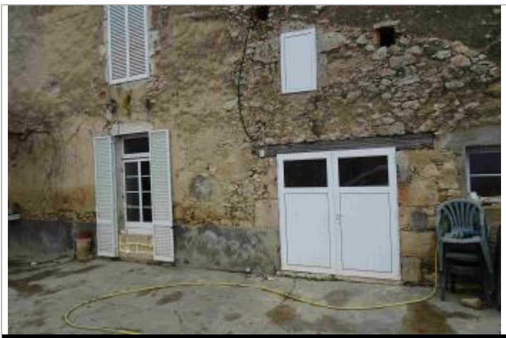
Vue du site - Photo Géosphair
