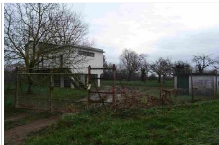
Vue du site - Photo Géosphair
