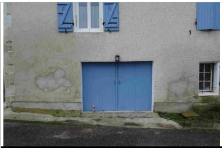
Vue du site - Photo Géosphair
