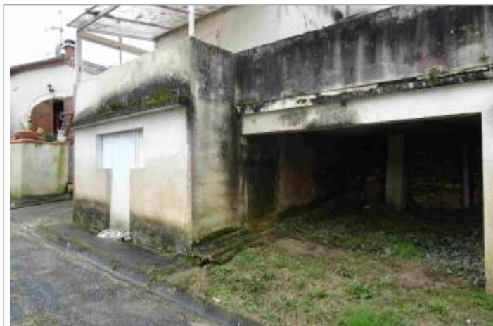
Vue du site - Photo Géosphair
