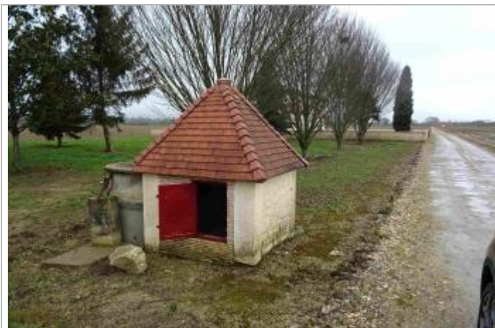
Vue du site - Photo Géosphair
