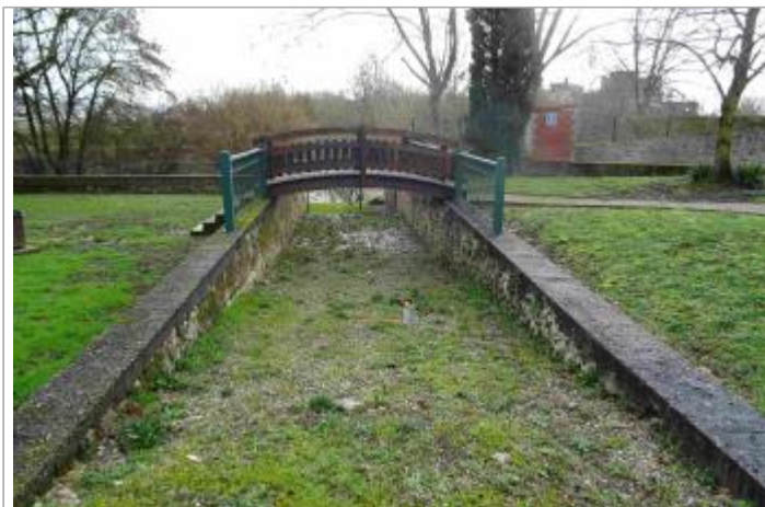
Vue du site - Photo Géosphair
