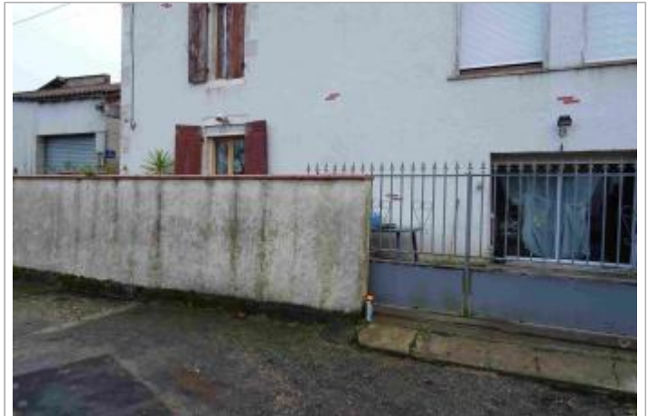
Vue du site - Photo Géosphair
