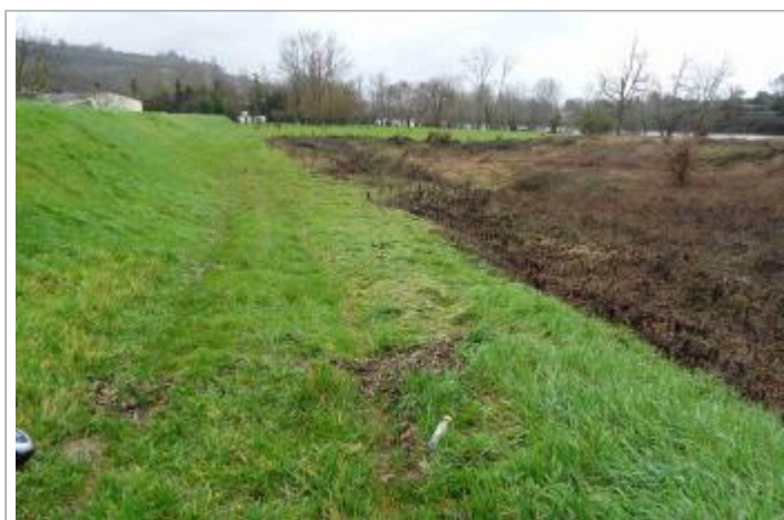
Vue du site - Photo Géosphair
