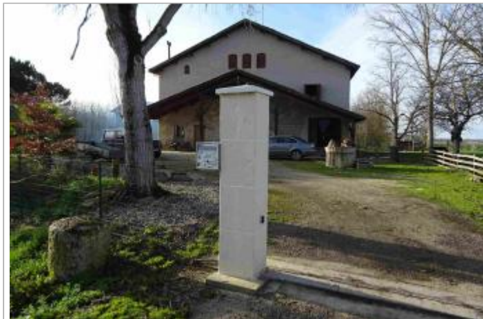
Vue du site - Photo Géosphair
