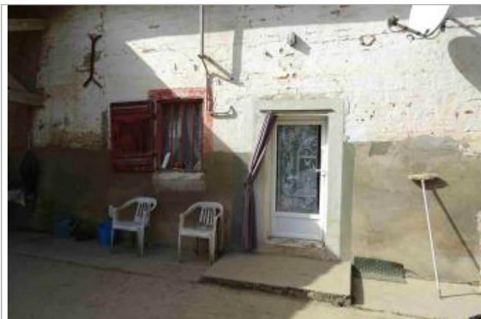
Vue du site - Photo Géosphair
