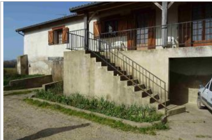
Vue du site - Photo Géosphair
